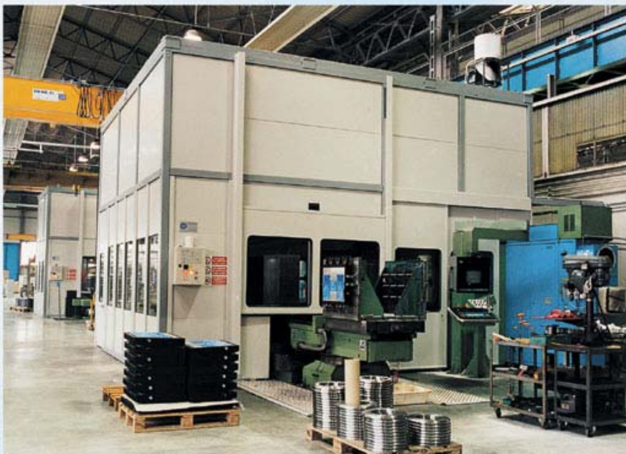
BONIFICA ACUSTICA INTEGRATA CON LA SICUREZZA DI DUE MANDELLI
